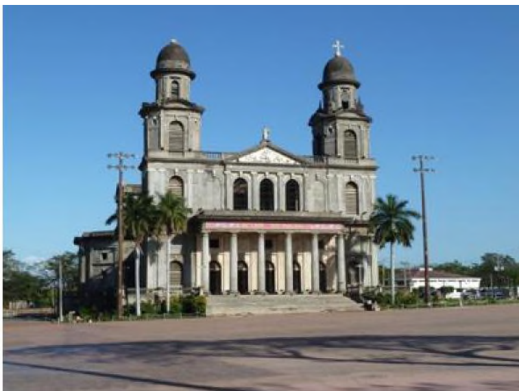
Nicaragua: Vom Erdbeben schwer betroffene Kathedrale in Managua
